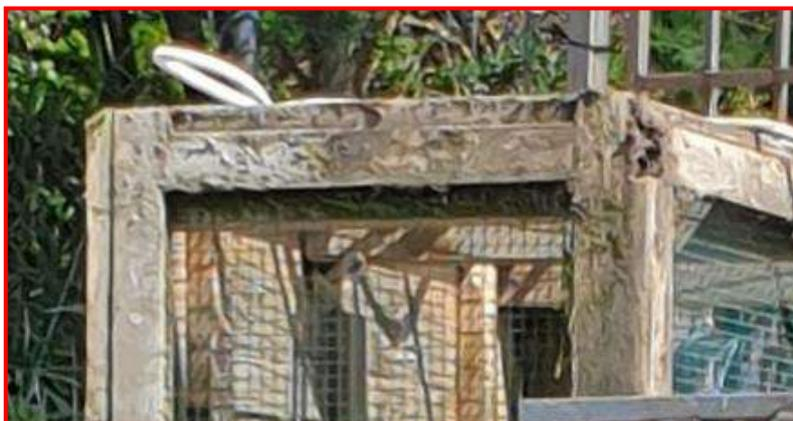
Foto 8.8: Viero in legno a fine stagione in cui si osserva la degradazione del legno. Nella foto sotto il dettaglio.
